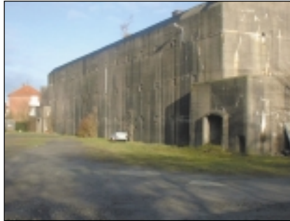
Zukünftiges Stadtteilzentrum im Hochbunker
